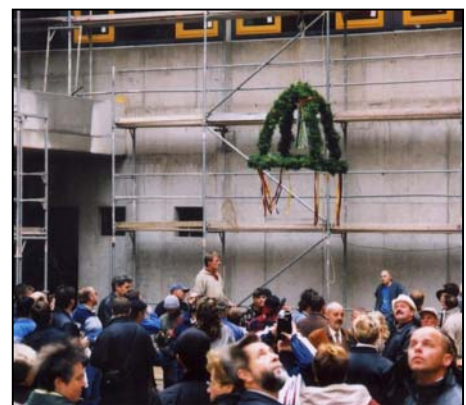
Die Richtkrone wird aufgezogen
